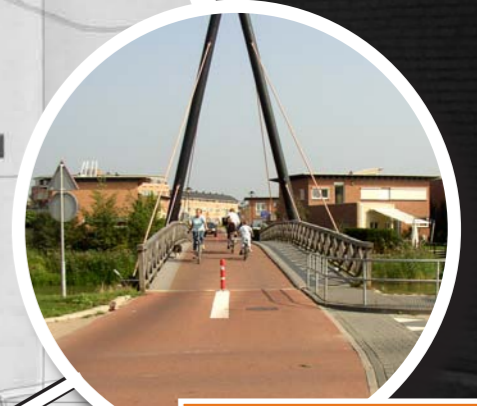
Fietsbrug tussen De Tuin en Strandmeer
